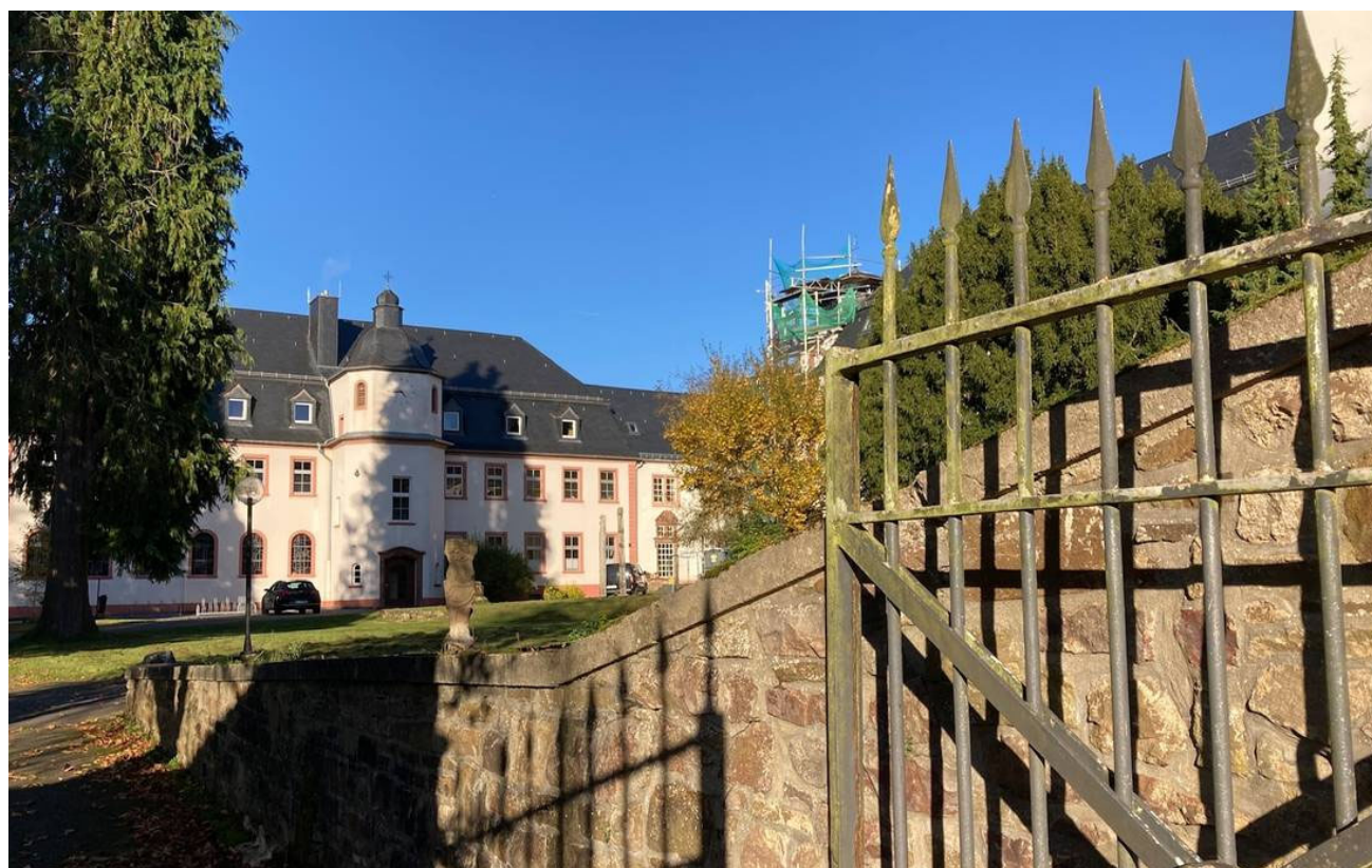
Der Gebäudekomplex der Vinzentiner mit Kloster und Schule in Niederprüm.
